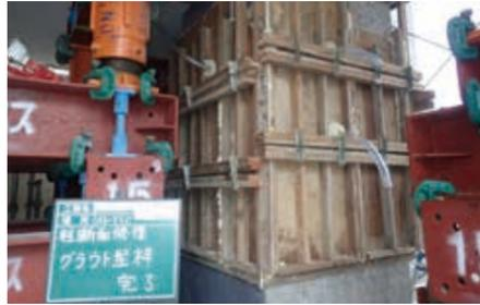
グラウト打設後のコンクリート浮き補修
