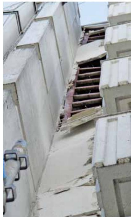
テナントビルの壁が崩落した状態
