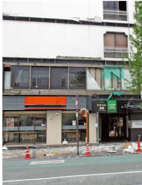
テナントビルの壁や窓ガラスが崩落して歩道に散乱した
