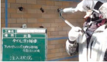
アンカーピンニングエポキシ樹脂全面注入工法注入
