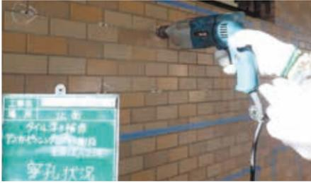
アンカーピンニングエポキシ樹脂全面注入工法穿孔
