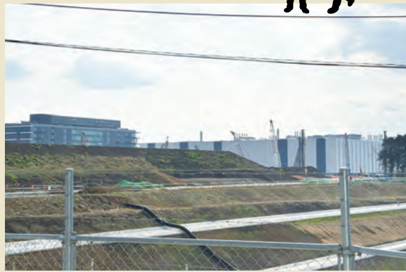
建設中のTSMC第2工場（2026年3月撮影）
