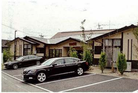
▲敷地面積は約 1400 m 2 で建築面積は約 530 m 2 。 駐車場は 15 台収容
